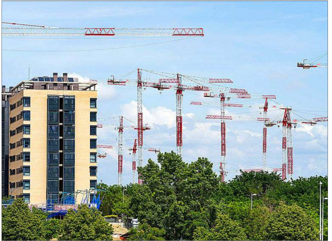
Varias viviendas en construcción en la Comunidad de Madrid. ÁNGEL NAVARRETE
