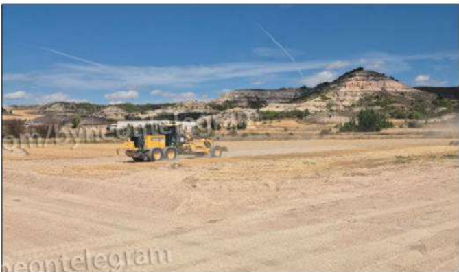
Obras en el polígono de Langa de Duero. HDS
